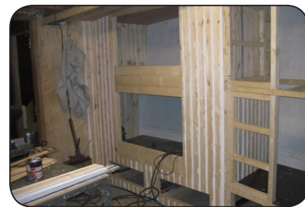
Kooien in aanbouw
